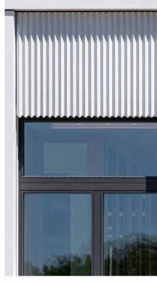
ALUMINIUM CLAD SLAB EDGES - WHITE
